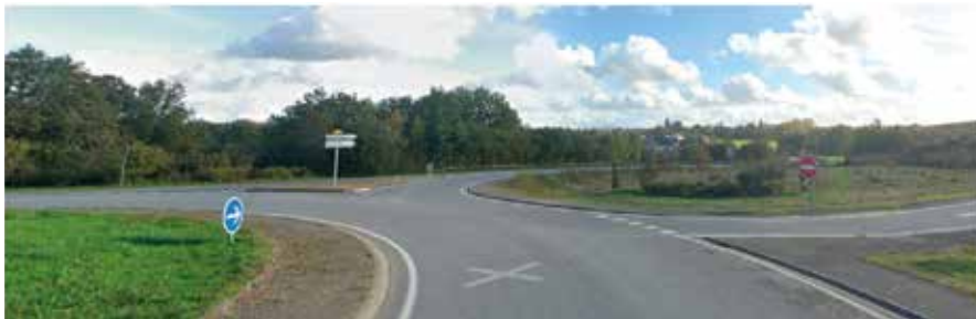
Entrée du bourg, sortie de la 2*2
