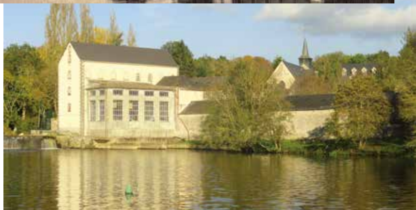
Construction d'une centrale électrique.
