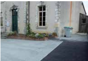
Rampe d'accès à la maison des jeunes.
