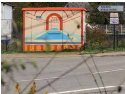
Le transformateur à l'entrée du bourg
