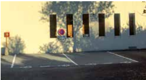
Places de stationnement PMR salle omnisports.
