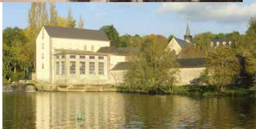
Construction d'une centrale électrique.
